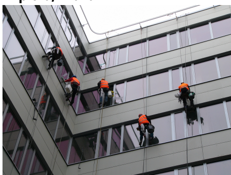
Mytí prosklených fasád na budově Explora, Praha
